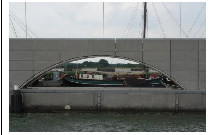
❸ Kaimauer in Lelystad (Ijsselmeer)
